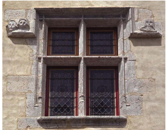
Fenêtre à meneau Renaissance.
