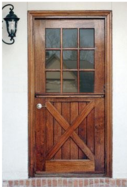
Contre-hus à partie haute vitrée.
